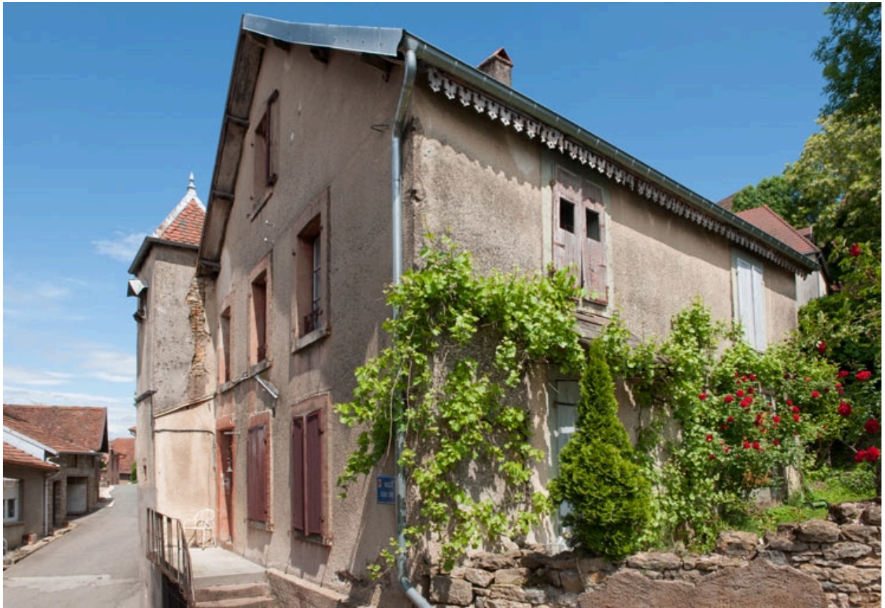
Façade antérieure et façade latérale droite.
