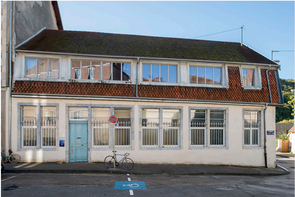
Façade nord de l'atelier.
