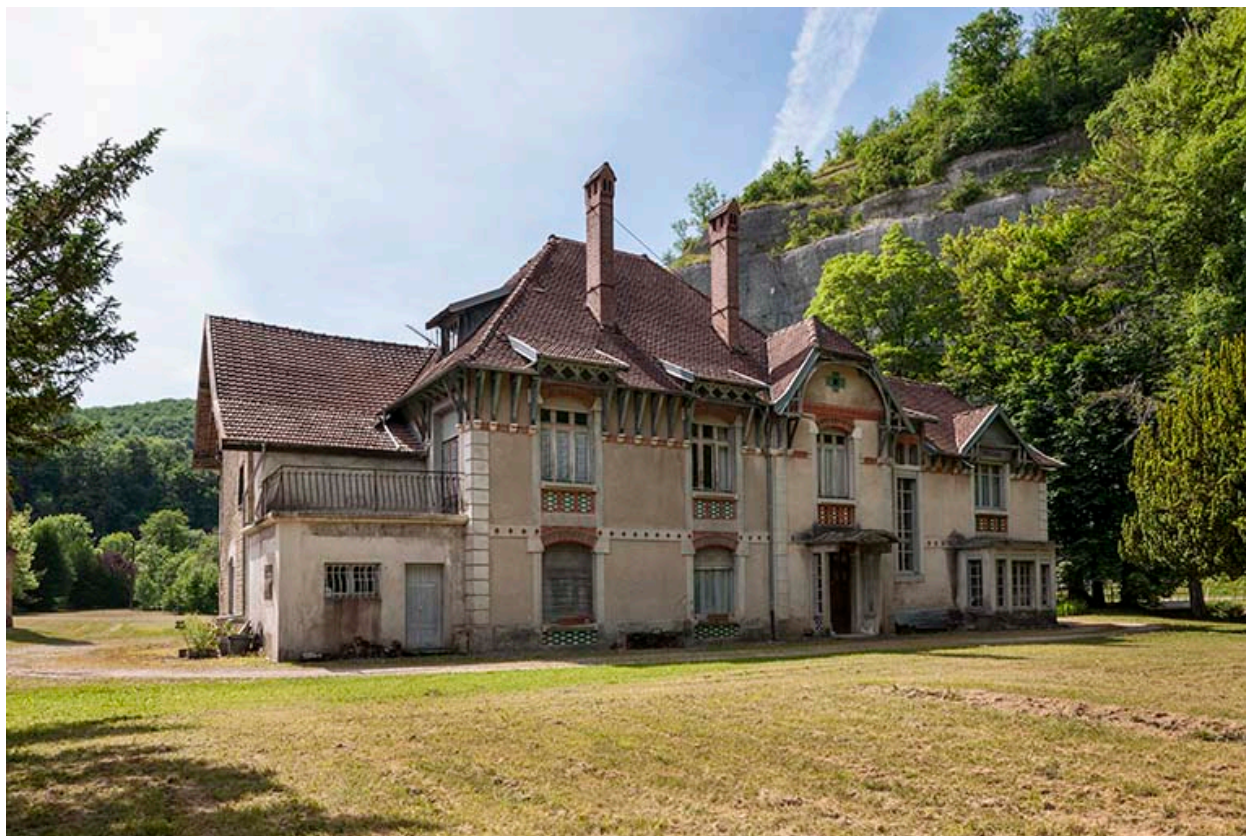
Façade est du logement patronal.
