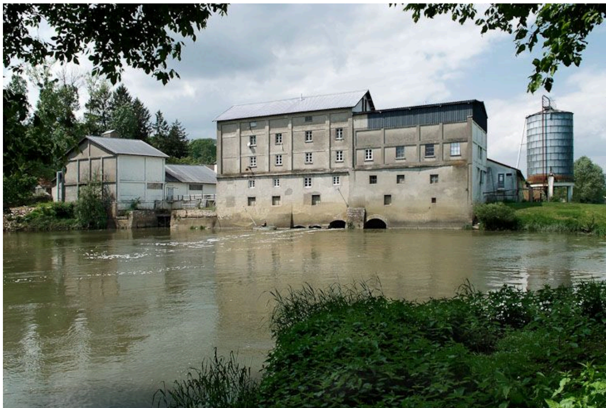
Le moulin : vue d'ensemble d'aval.
