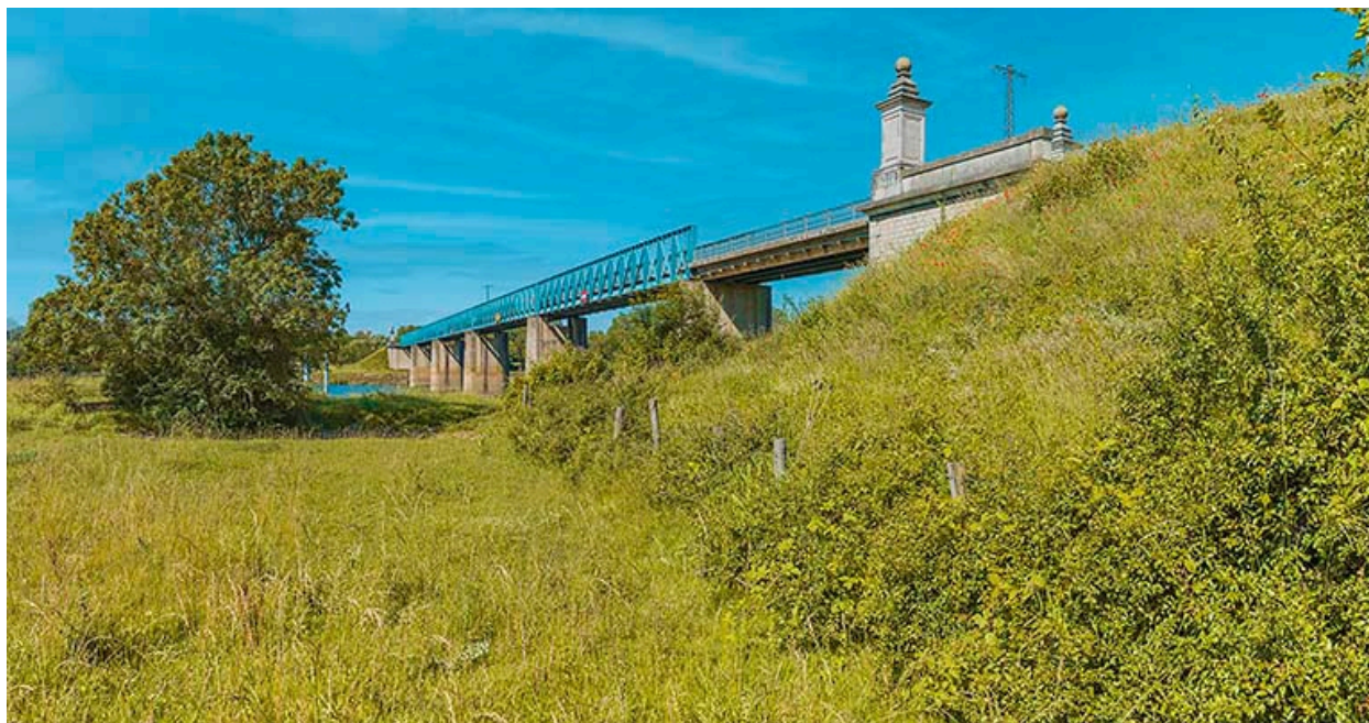
Vue d'ensemble du pont.
