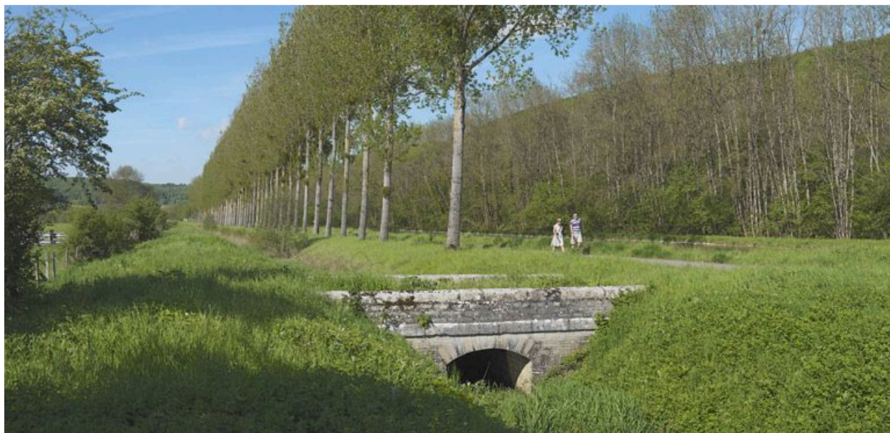
Pont sur rigole rive gauche.
