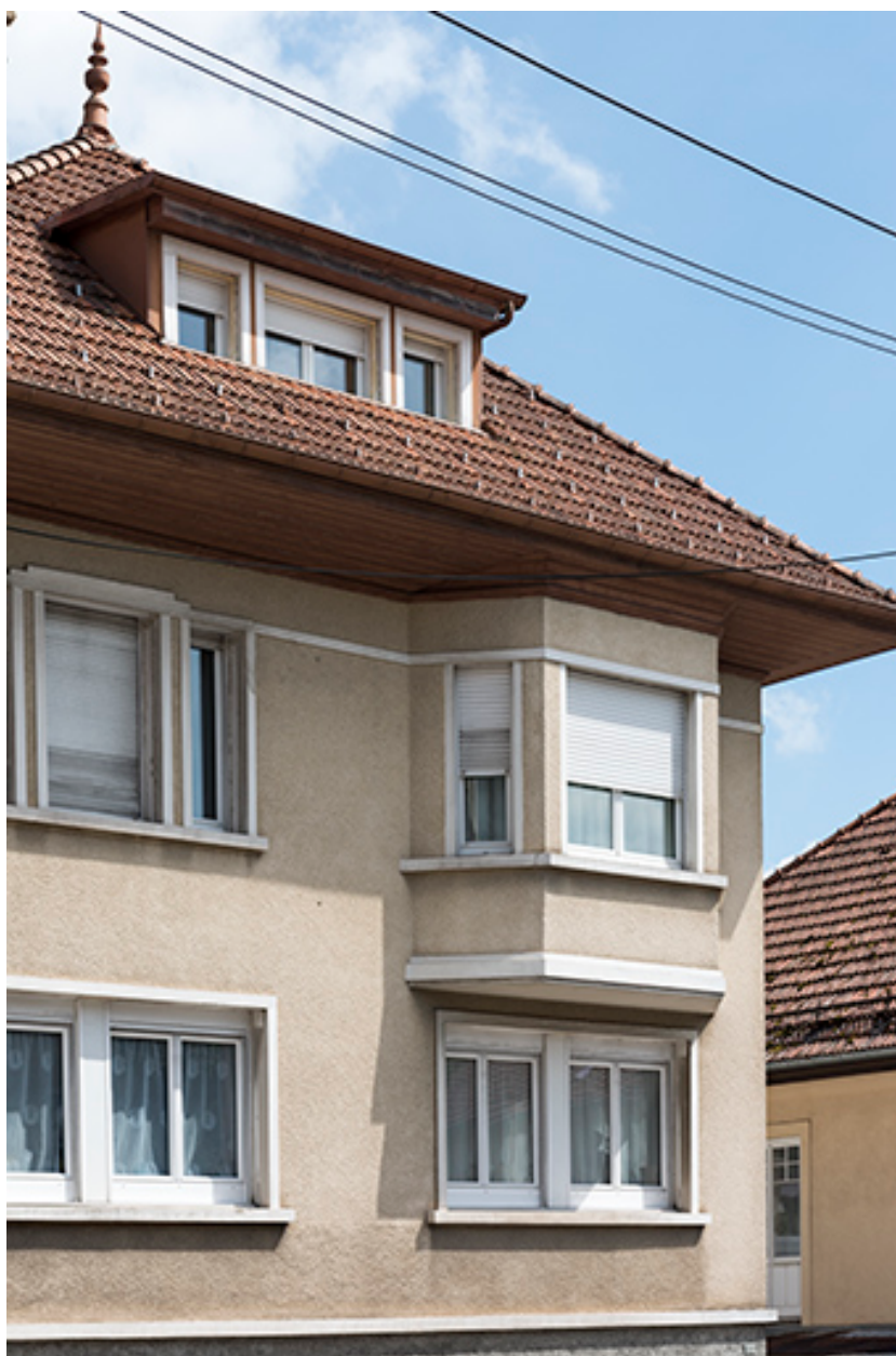
Façade antérieure : baies des étages et oriel.
