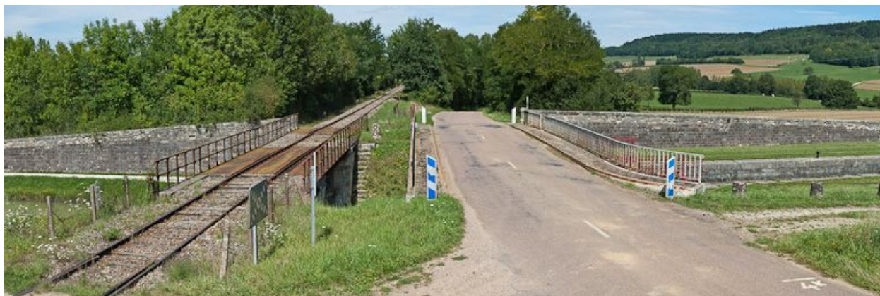
Vue des deux ponts sur écluse.
