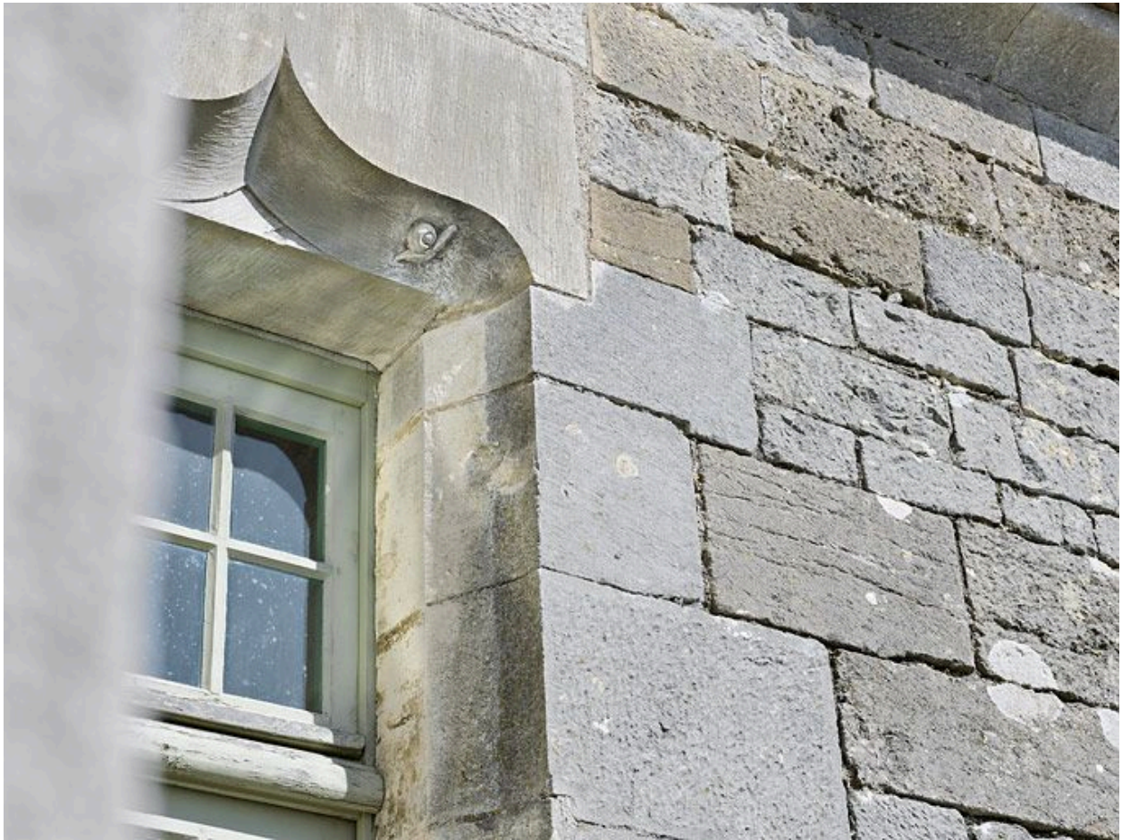
Fenêtre du mur sud surmontée d'une accolade sculptée d'un escargot.
