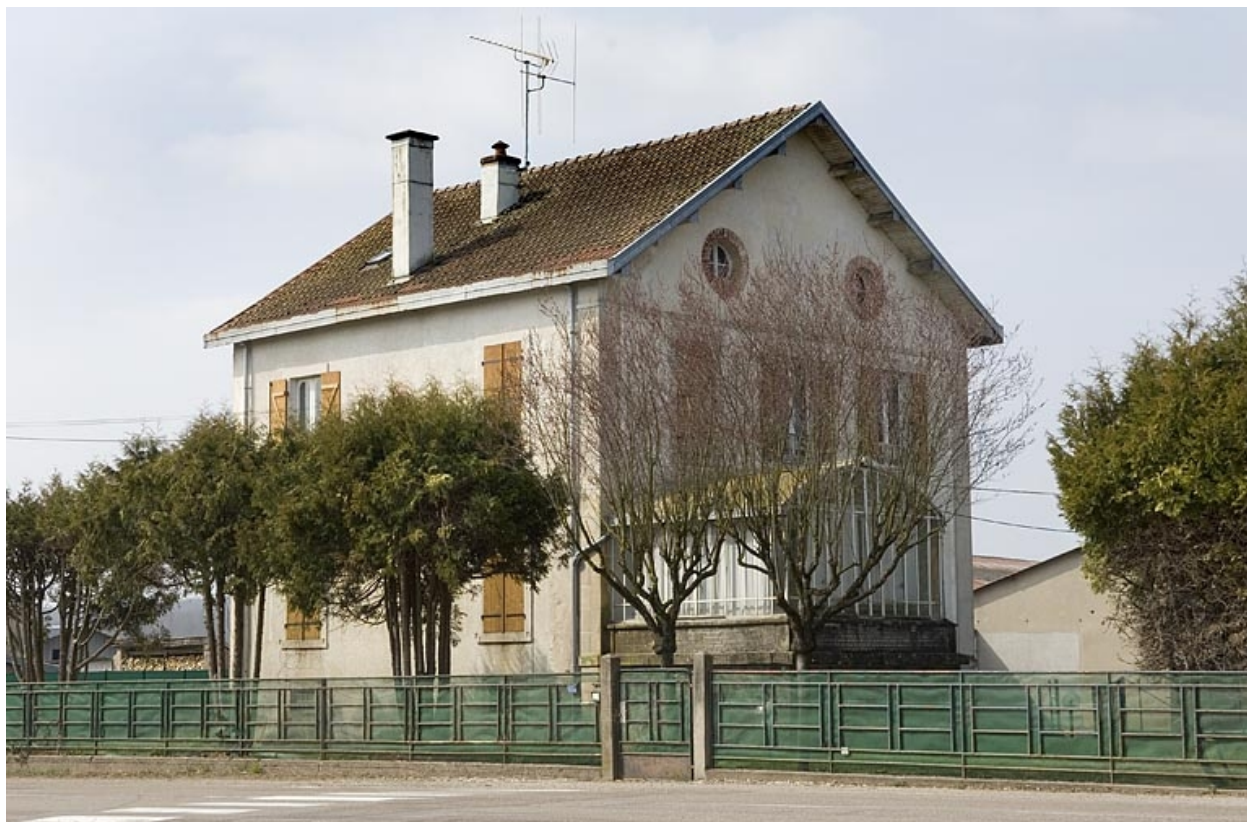
Logement patronal depuis l'est.
