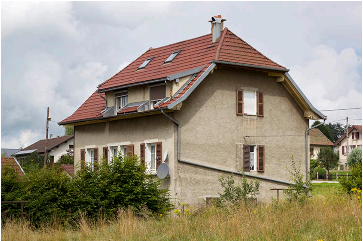
Façades postérieure et latérale gauche.
