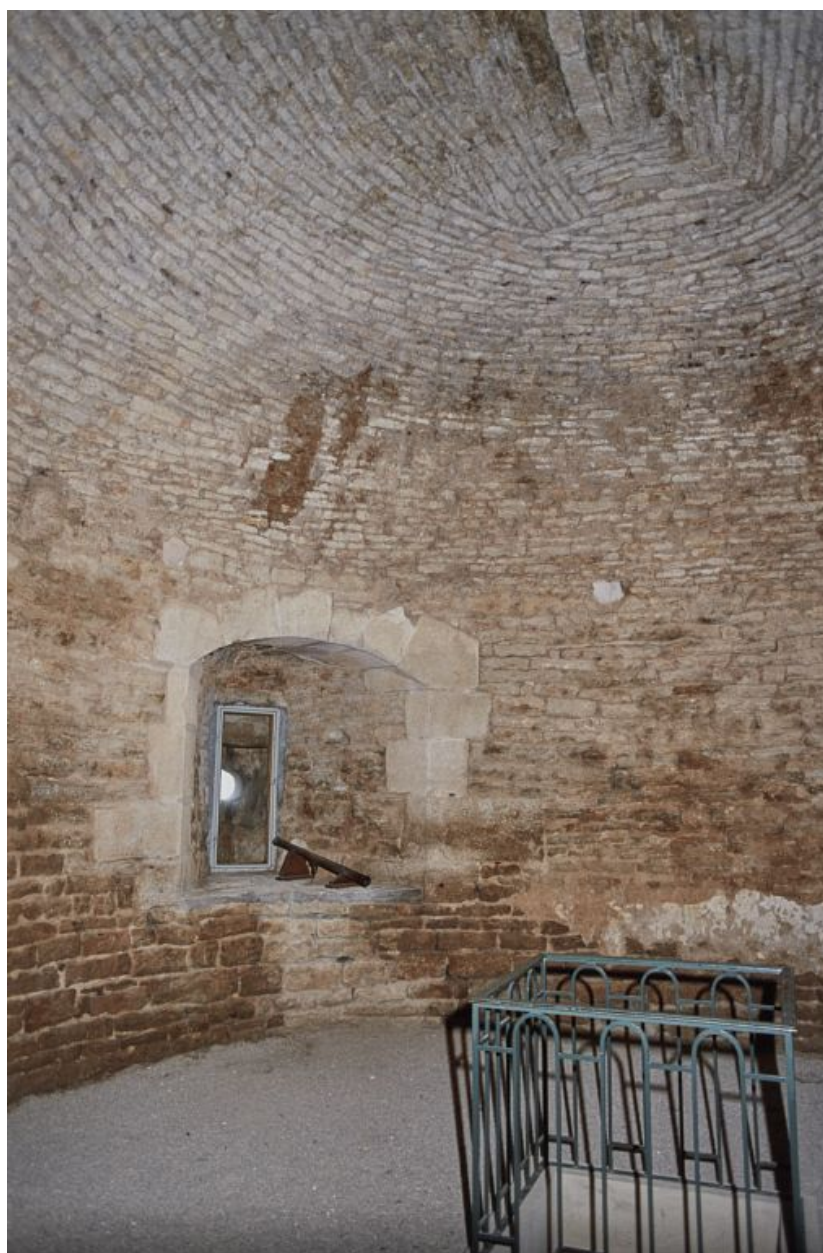
Tour sud, partie couverte en cul-de-four.
