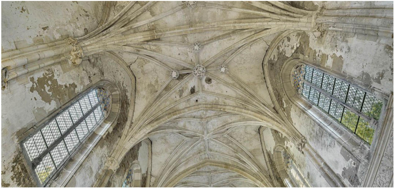
Intérieur de la chapelle : voûtes de la nef.
