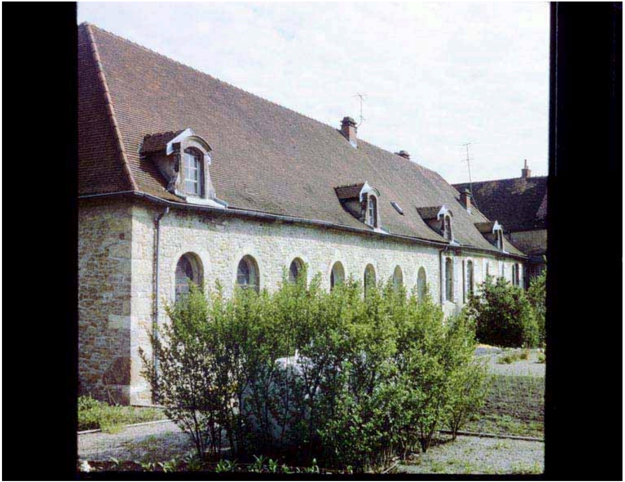
Vue du bâtiment principal.
