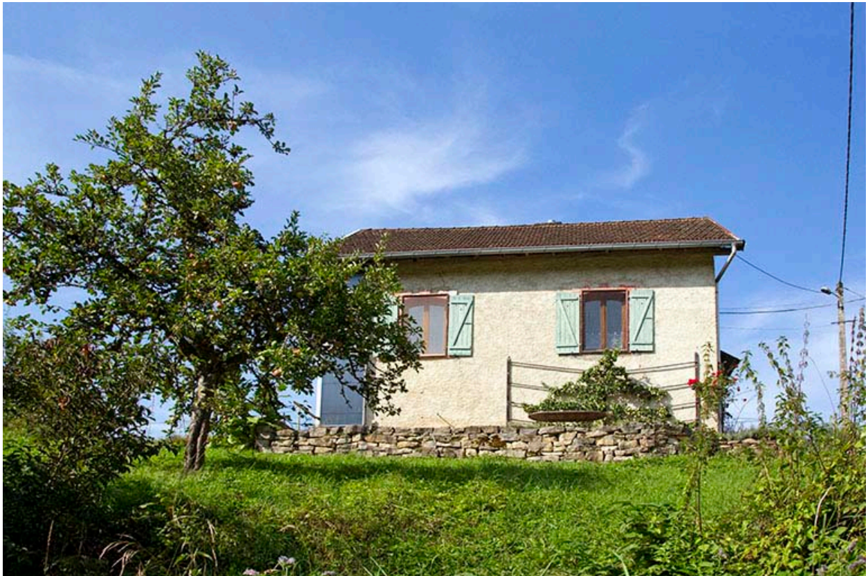
Logement d'ouvriers : façade postérieure.
