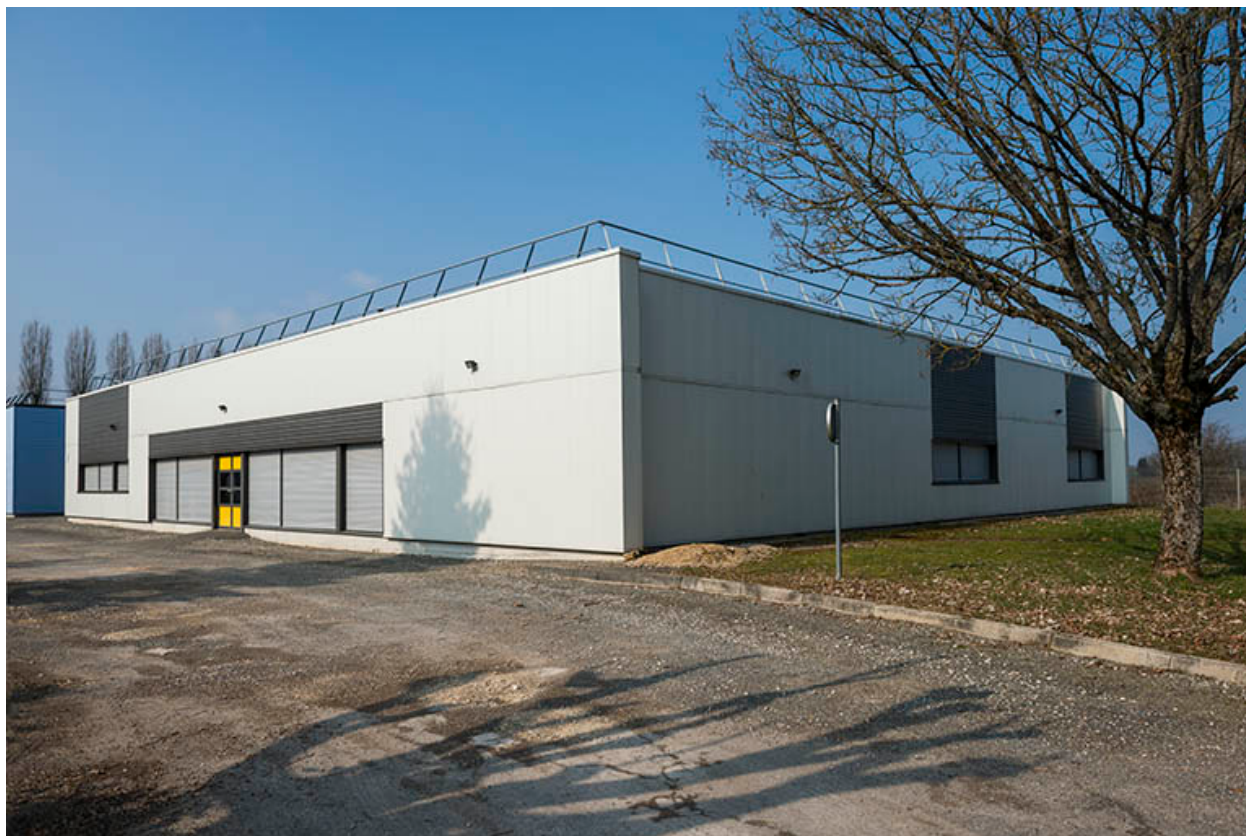
Angle sud-est des ateliers.
