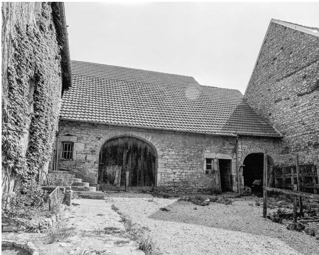
Dépendances et escaliers menant à l'habitation.
