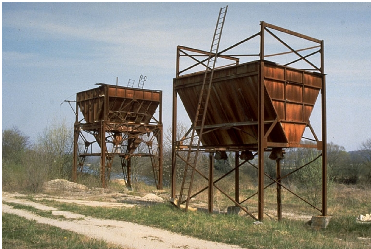
Trémies du poste de chargement.
