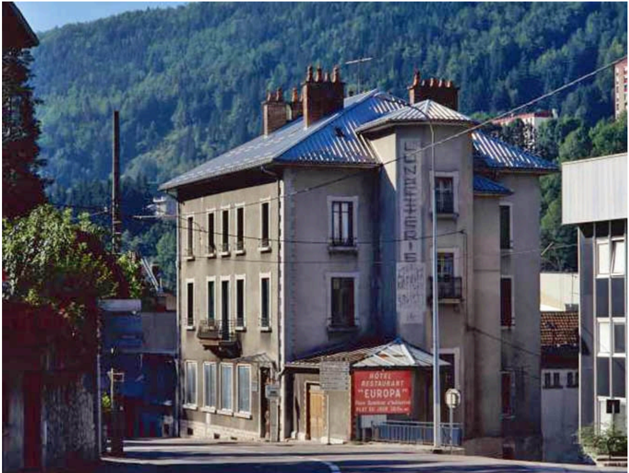
Façades antérieure et latérale droite.
