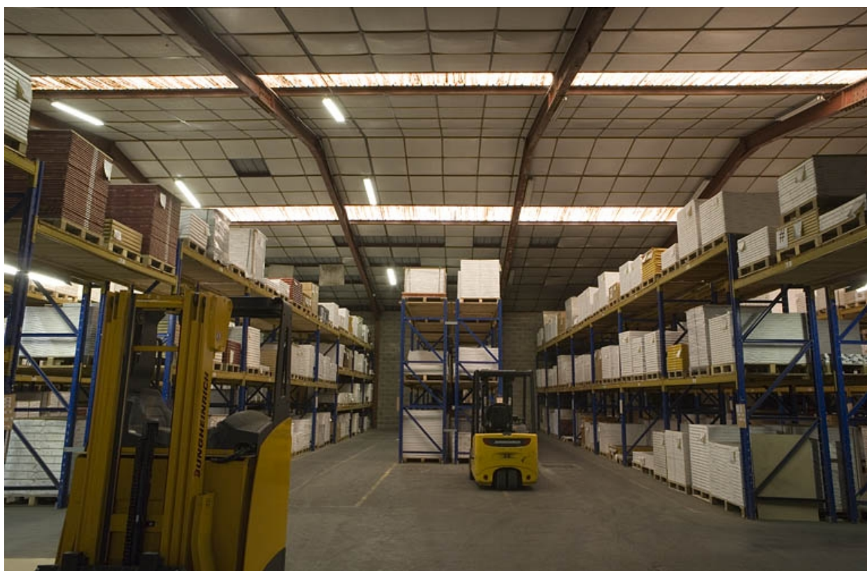
Magasin industriel (récent). Vue intérieure.
