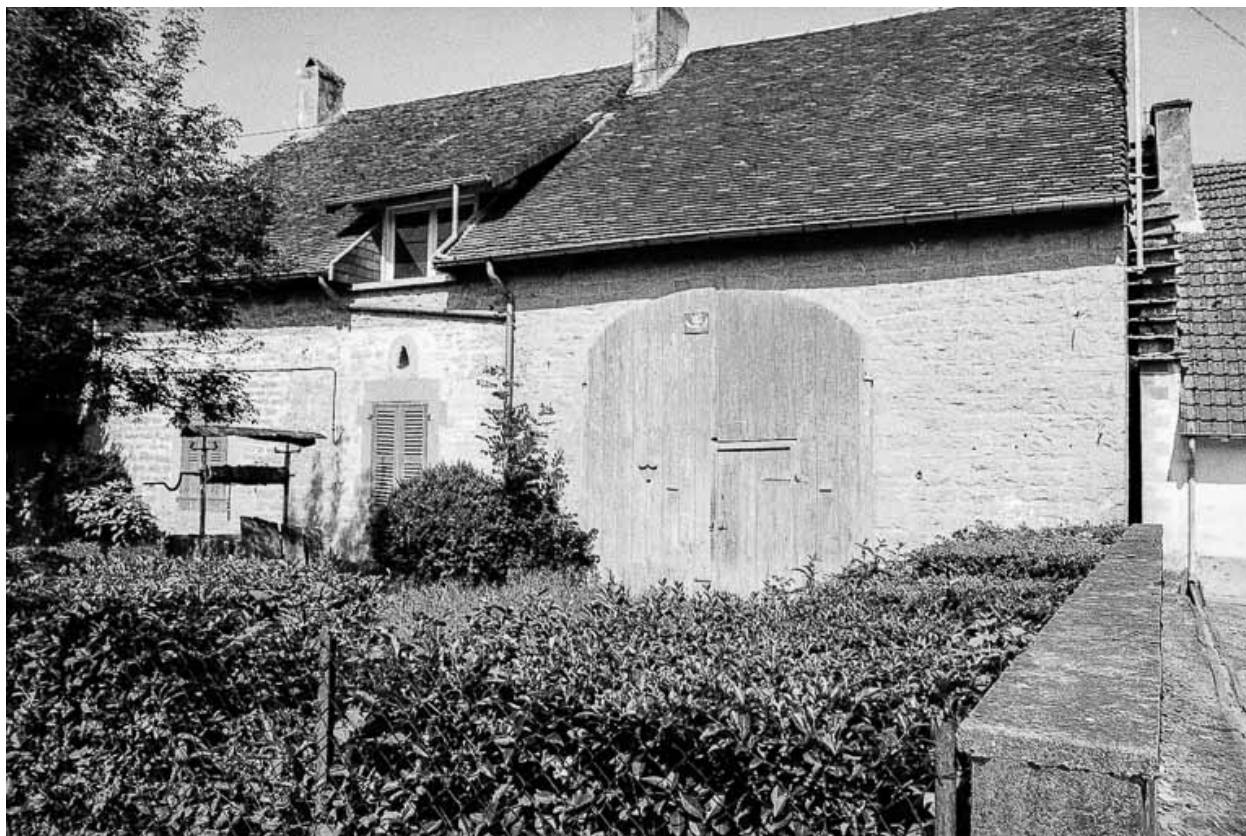
Ferme cadastrée 1984 B 502 : façade antérieure et grange.
