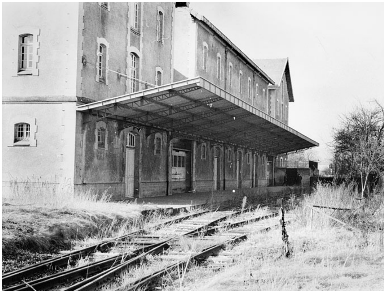
Embranchement ferroviaire et quai de chargement.
