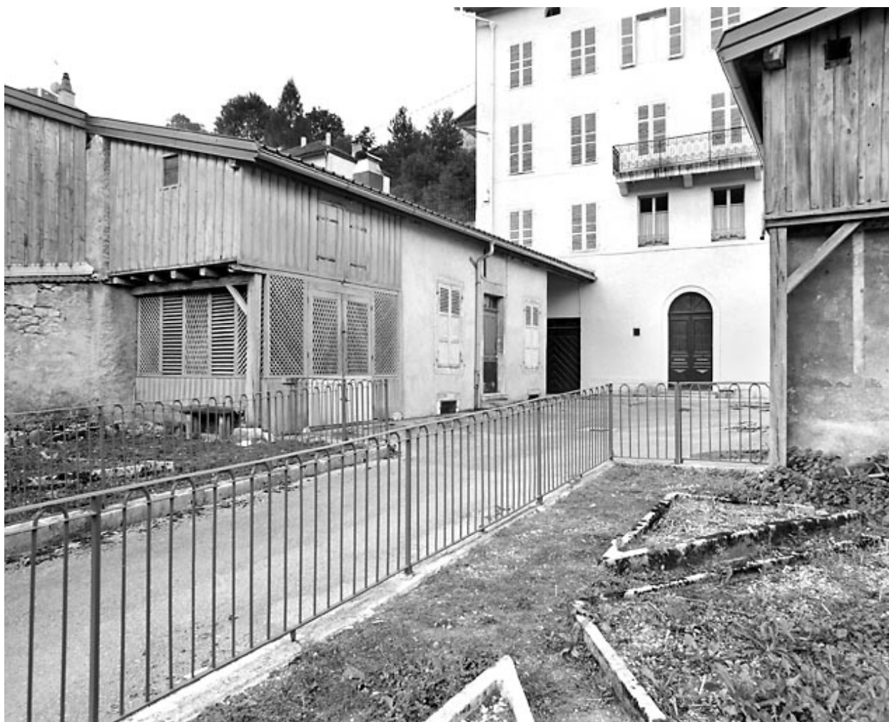
Jardin, cour et bâtiment sud.
