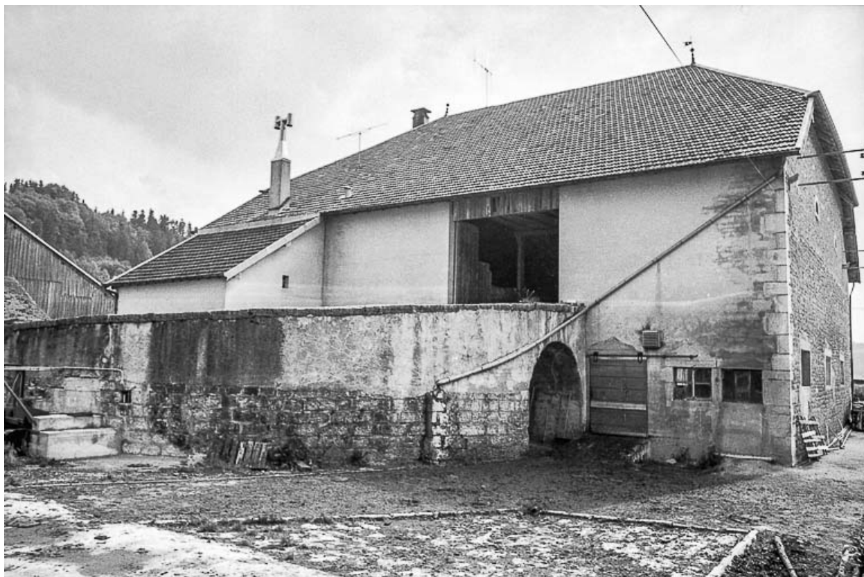
Ferme cadastrée 1962 E 281 bis : façade latérale droite.
