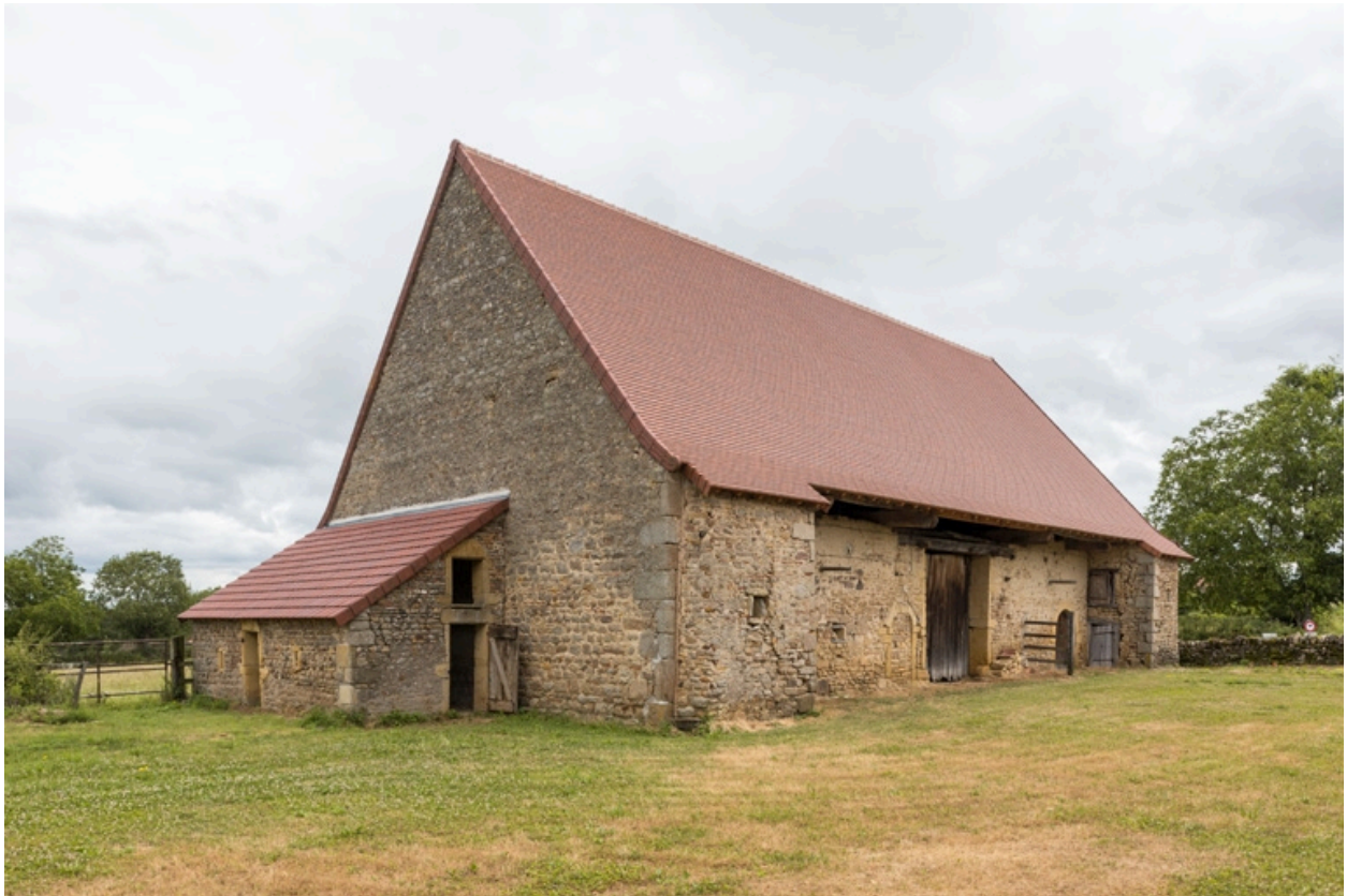
Vue de la grange, depuis l'ouest
