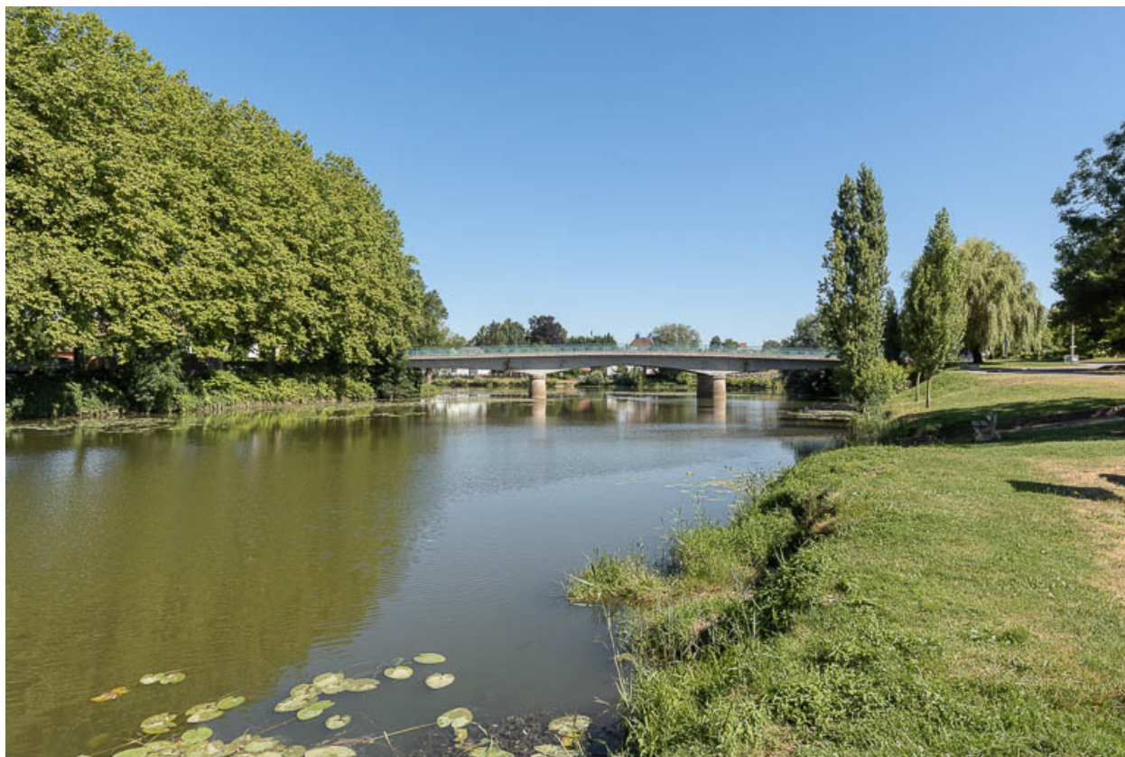
Vue générale du pont et du site.
