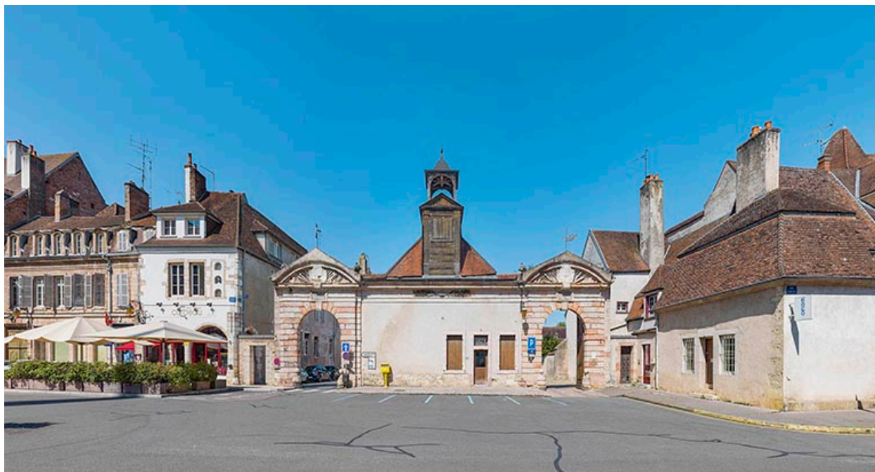
Vue d'ensemble depuis la rue Carnot.
