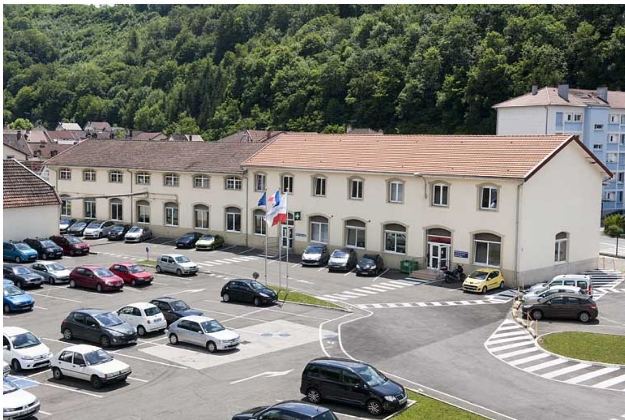
Bâtiment des bureaux depuis le nord-est.
