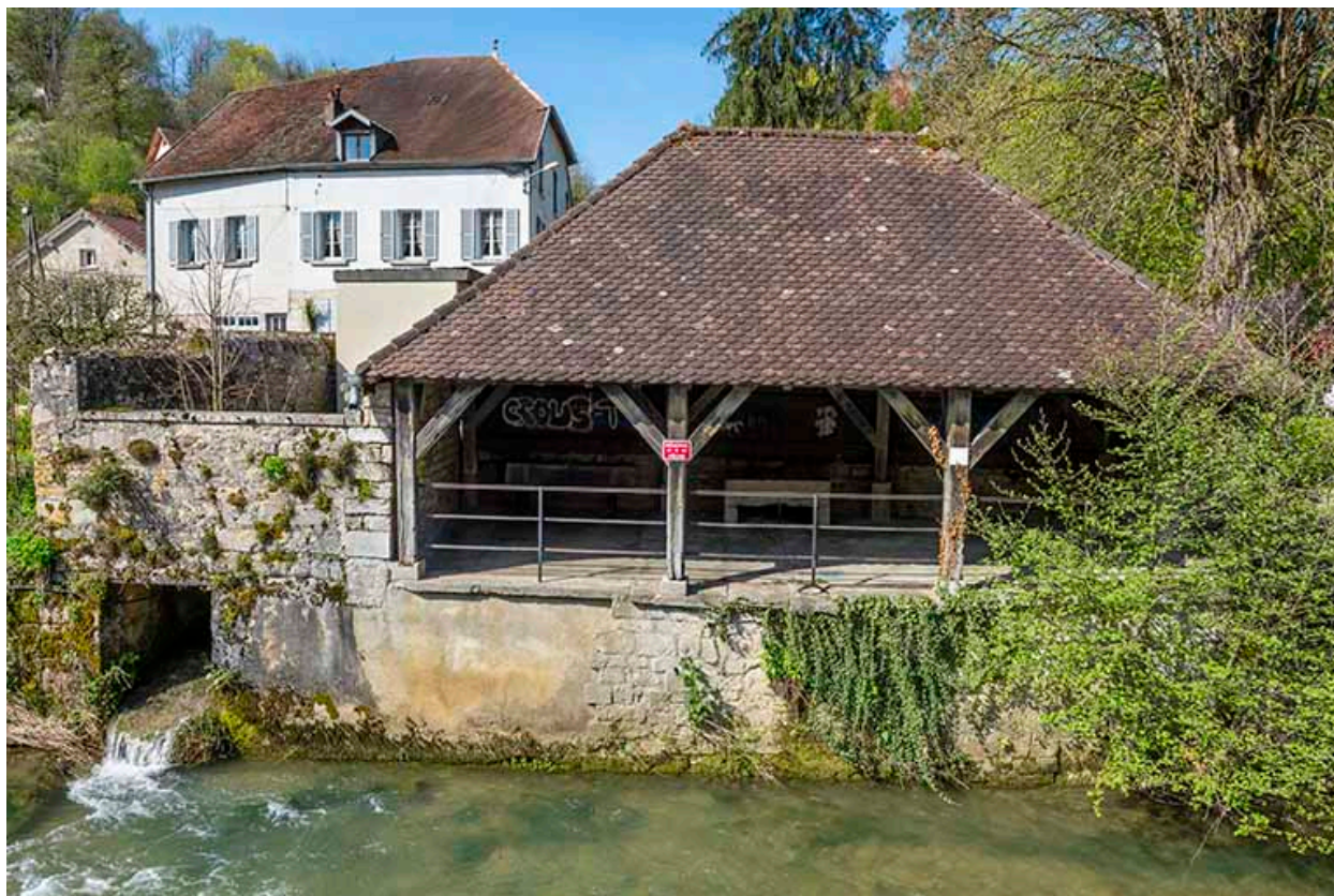
Vue depuis la rive droite de la Furieuse.
