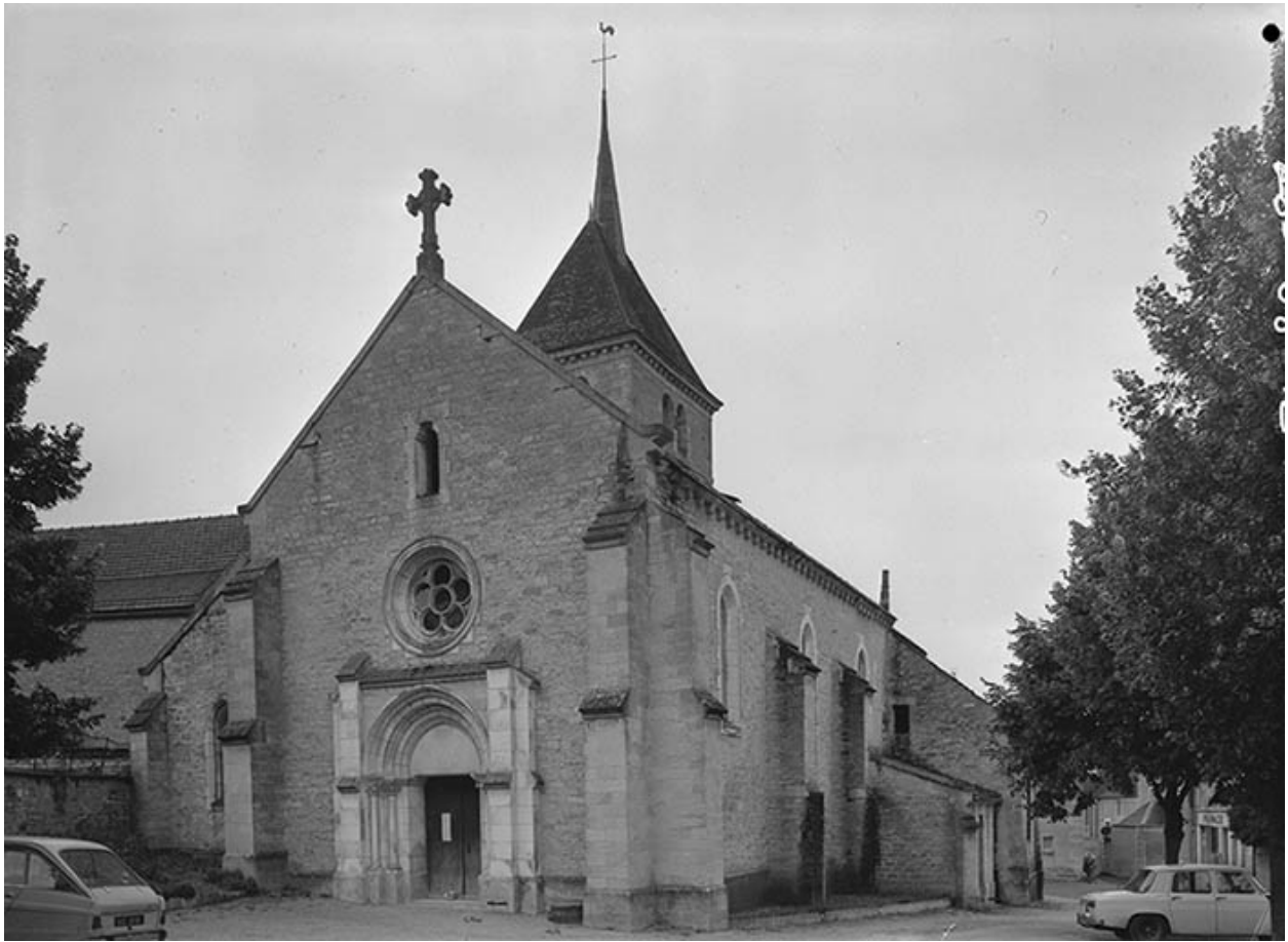
Façade occidentale avec portail.
