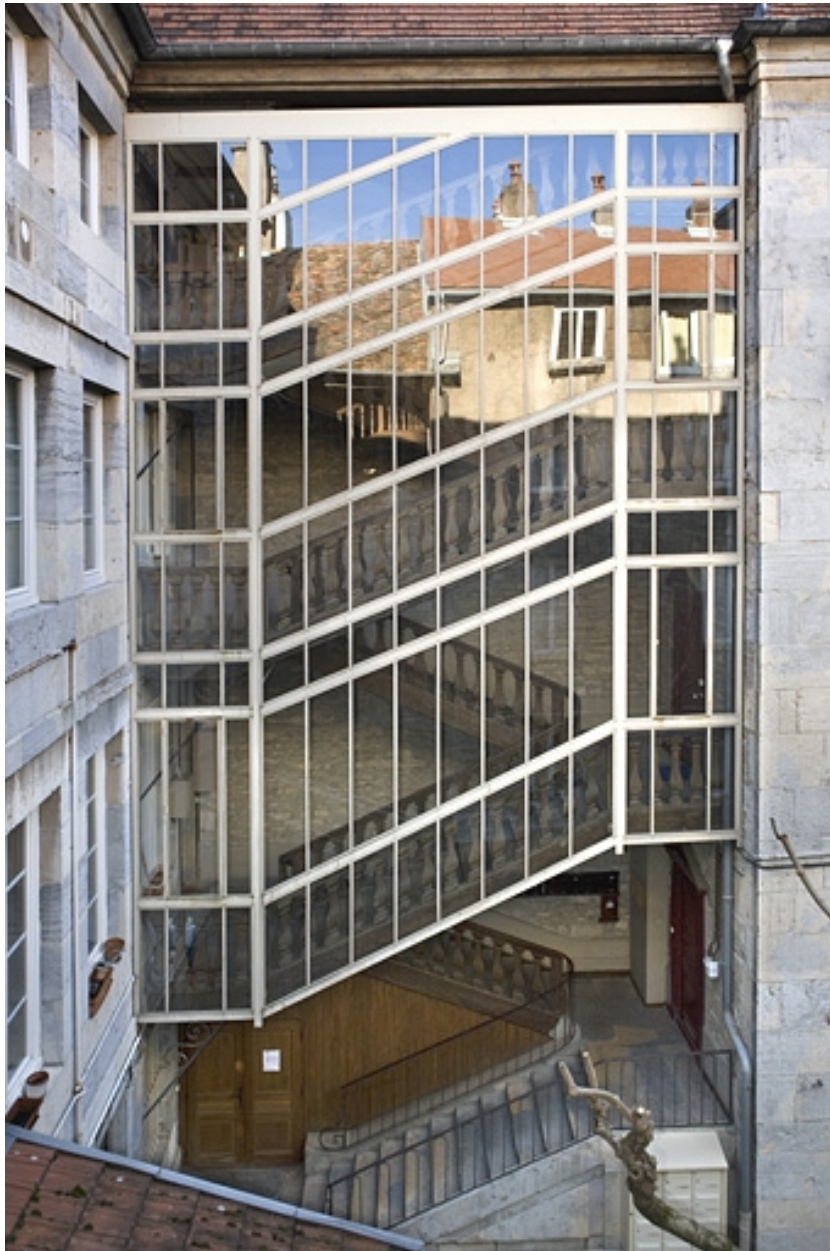
Vue d'ensemble premier escalier à cage ouverte, de face.
