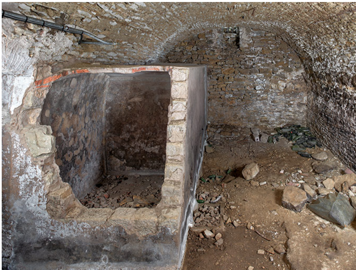
Cave située sous le logis du corps de ferme, avec cuve de vinification.
