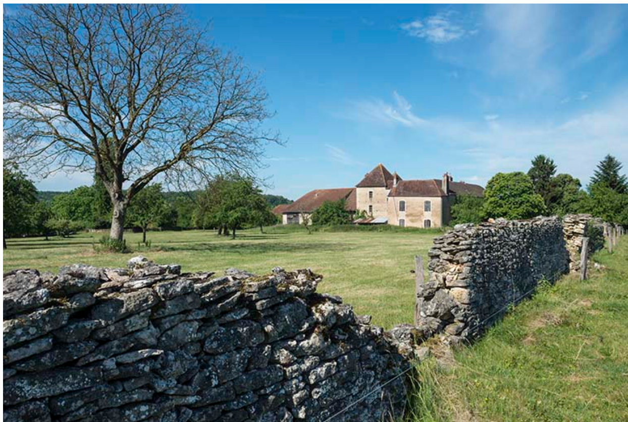
La façade orientale de la maison forte.
