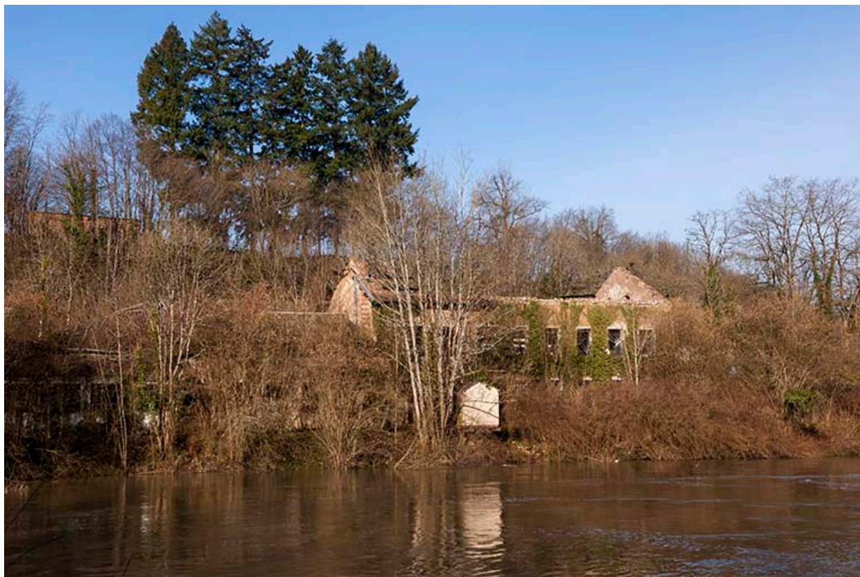
Atelier de fabrication incendié.
