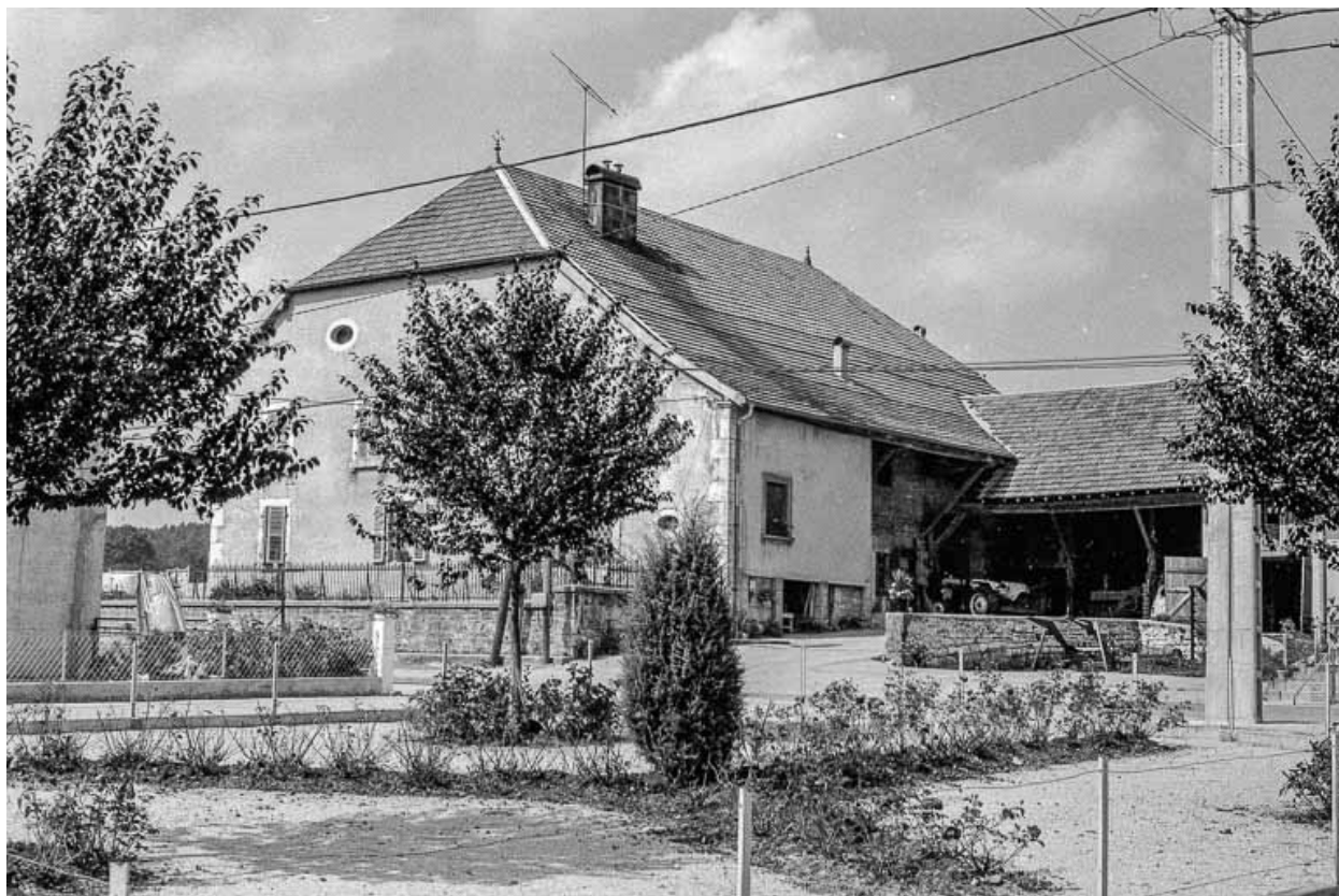
Façades sur cour.
