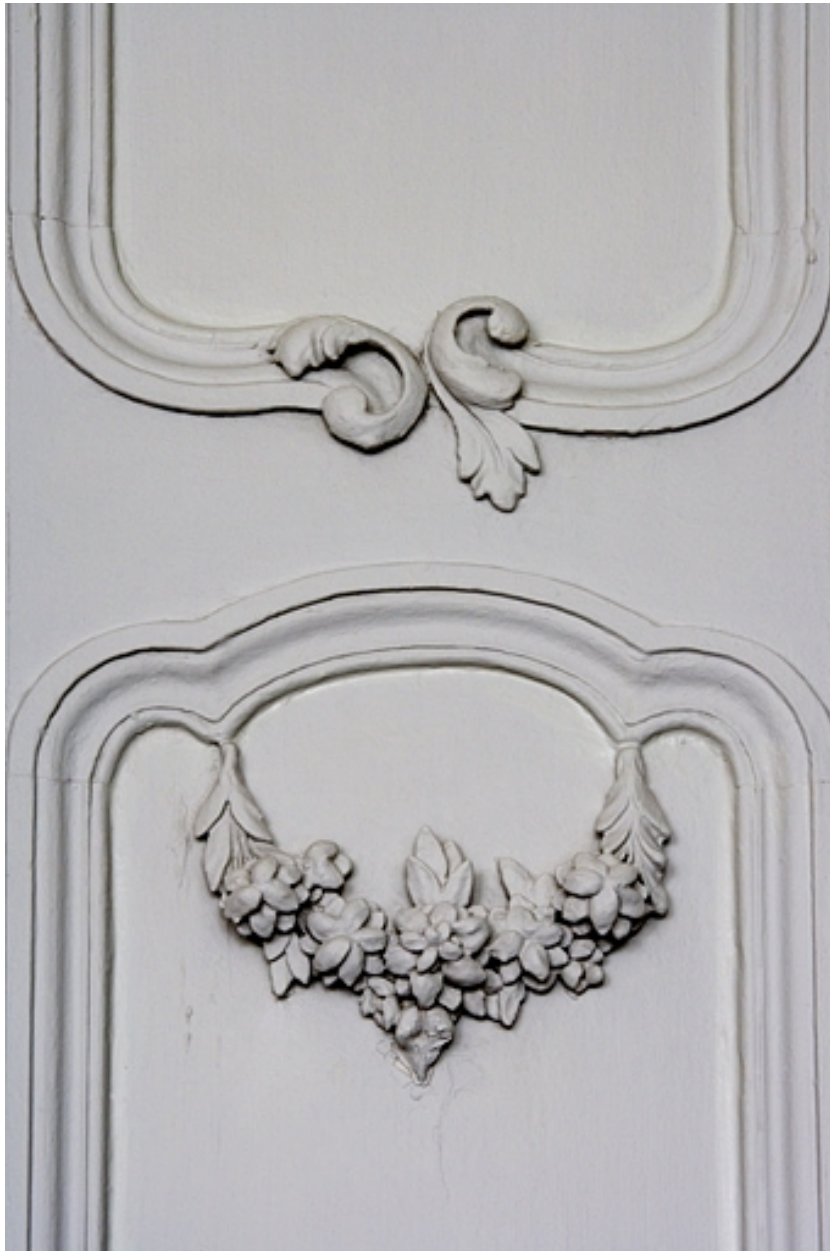
Intérieur, rez-de-chaussée : détail d'une petite guirlande de fleurs, lambris du salon.
