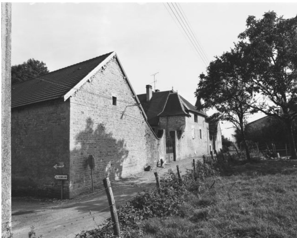
Demeure située rue du Moulin.
