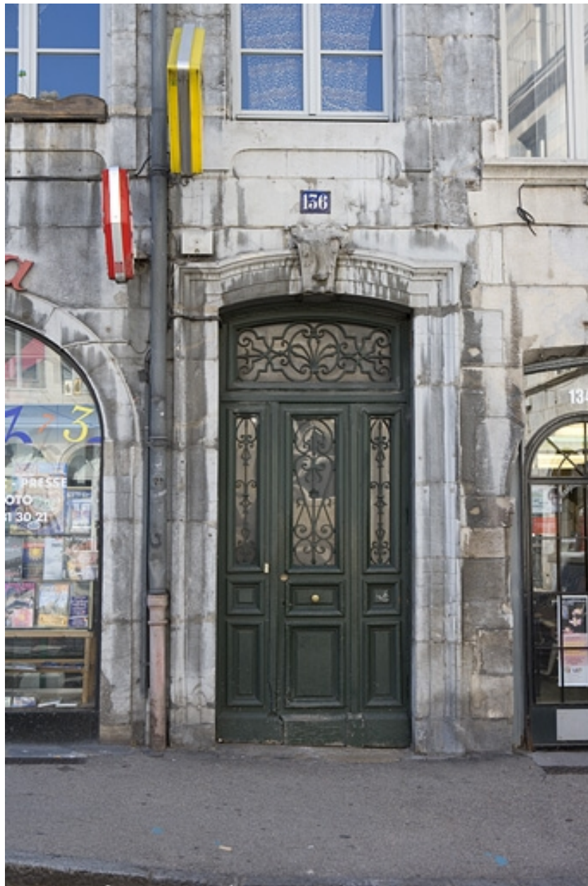
Détail de la porte d'entrée.
