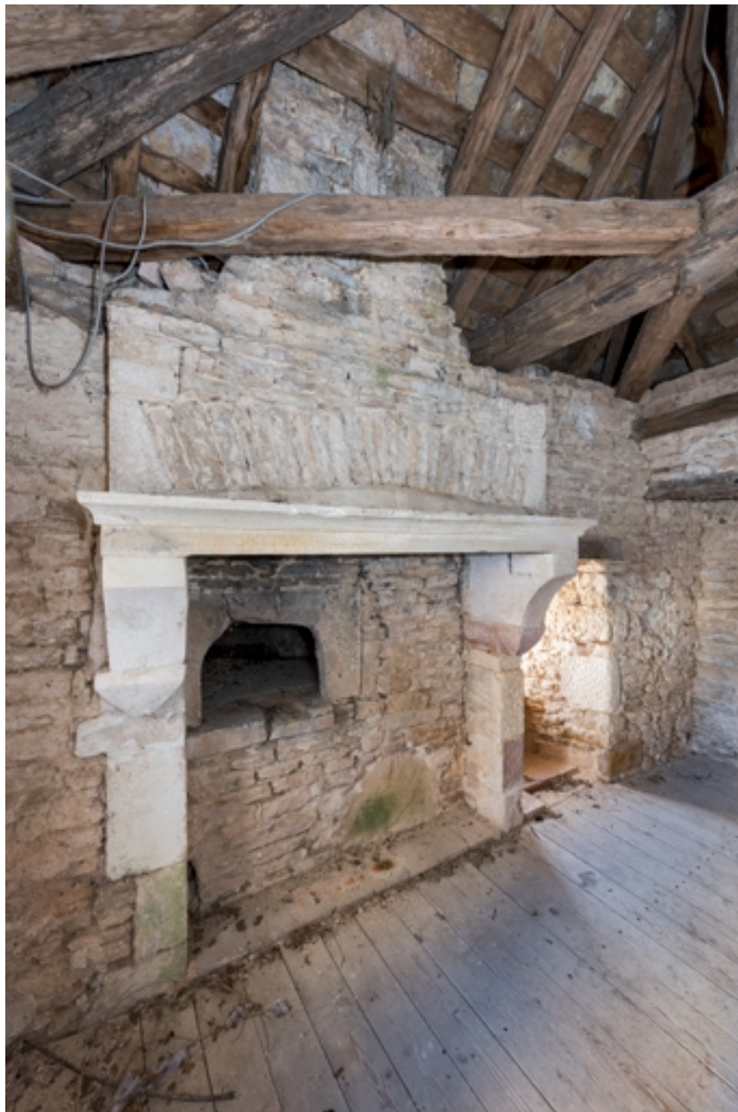
Vue intérieure de la cheminée et de la gueule du four.
