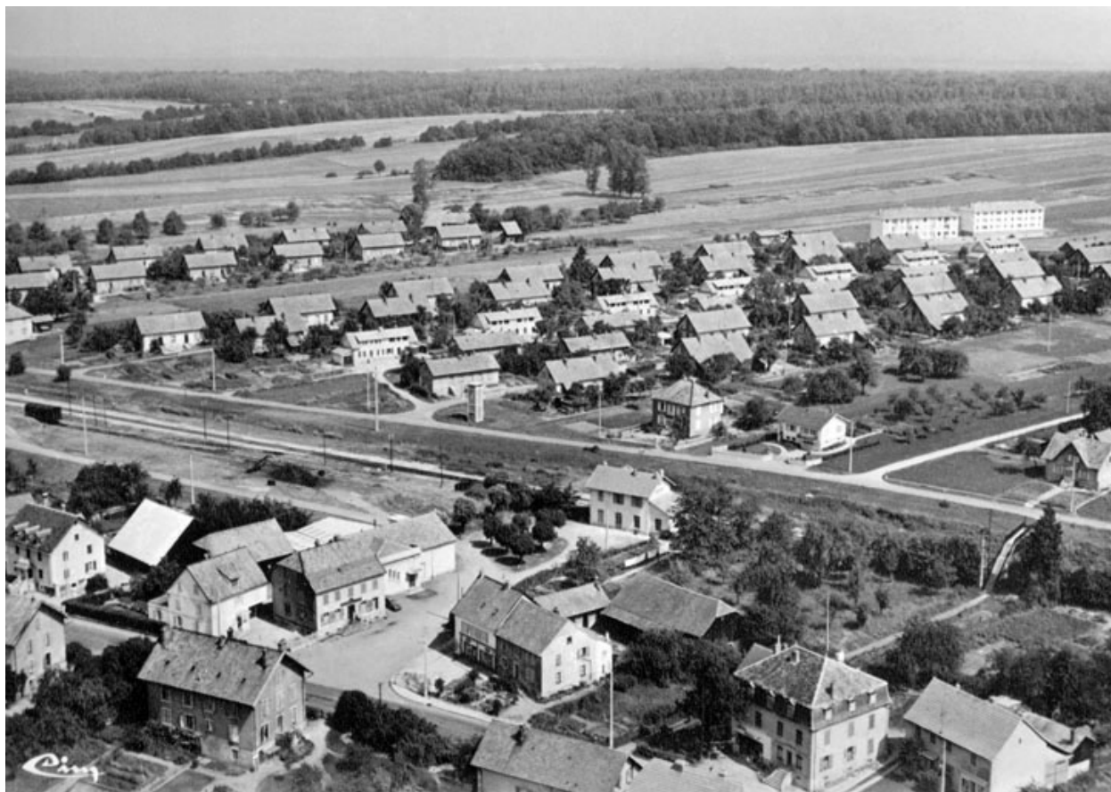
Grandvillars (Ter.-de-Belfort.). Vue générale.
