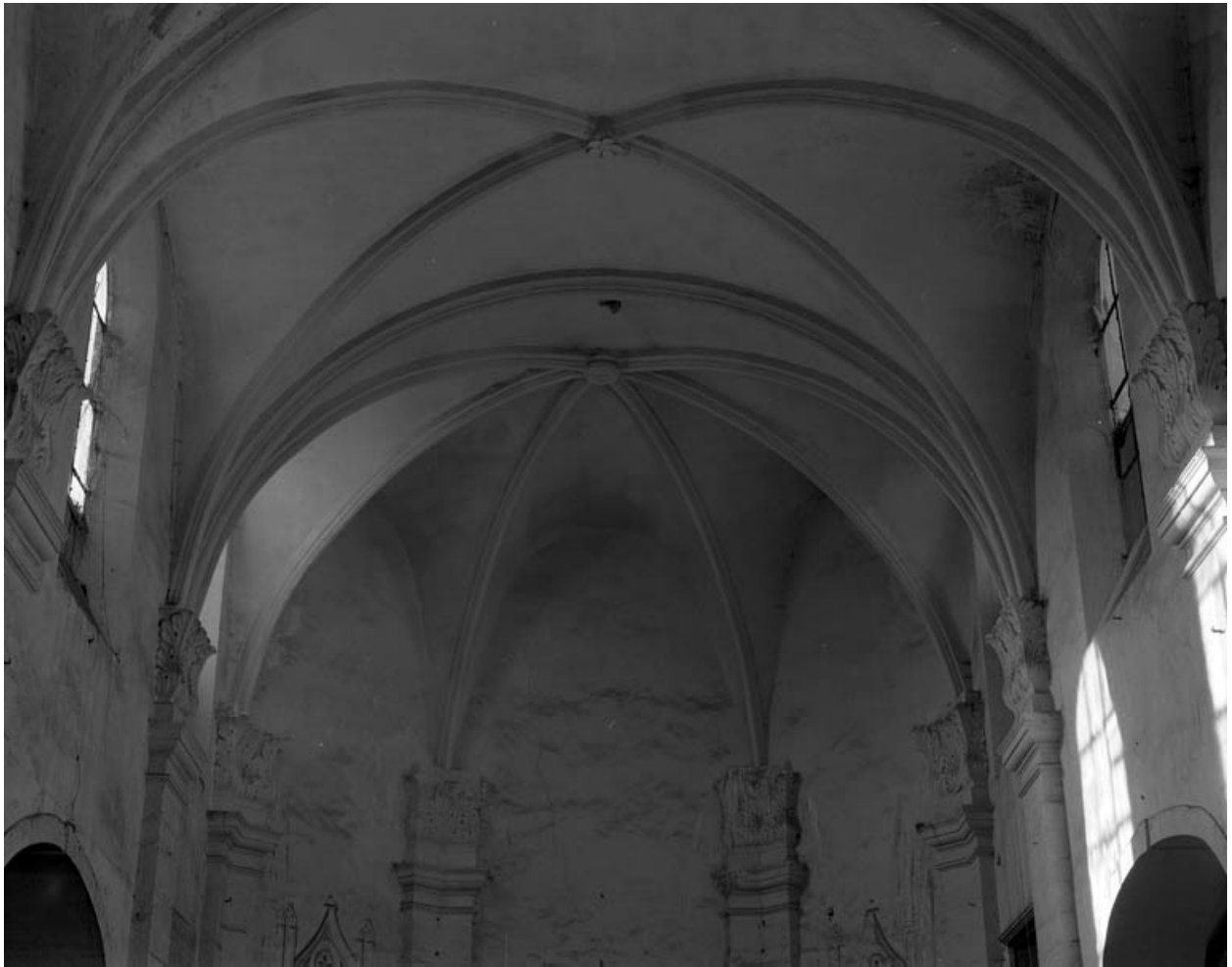
Chapelle : intérieur, voûtes du choeur en 1989.
