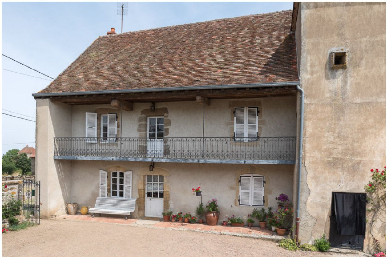
Façade antérieure de la maison
