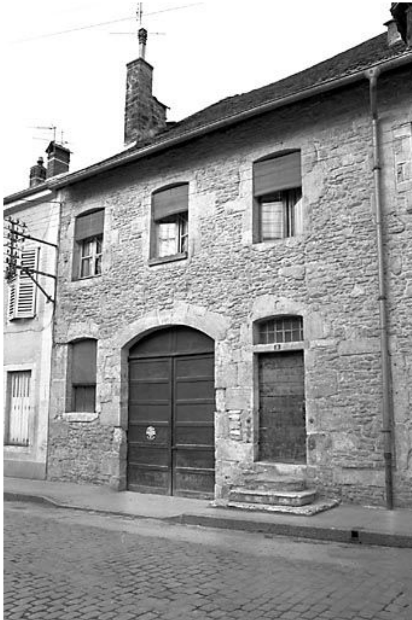
Maison située 8 rue Saint-Laurent.
