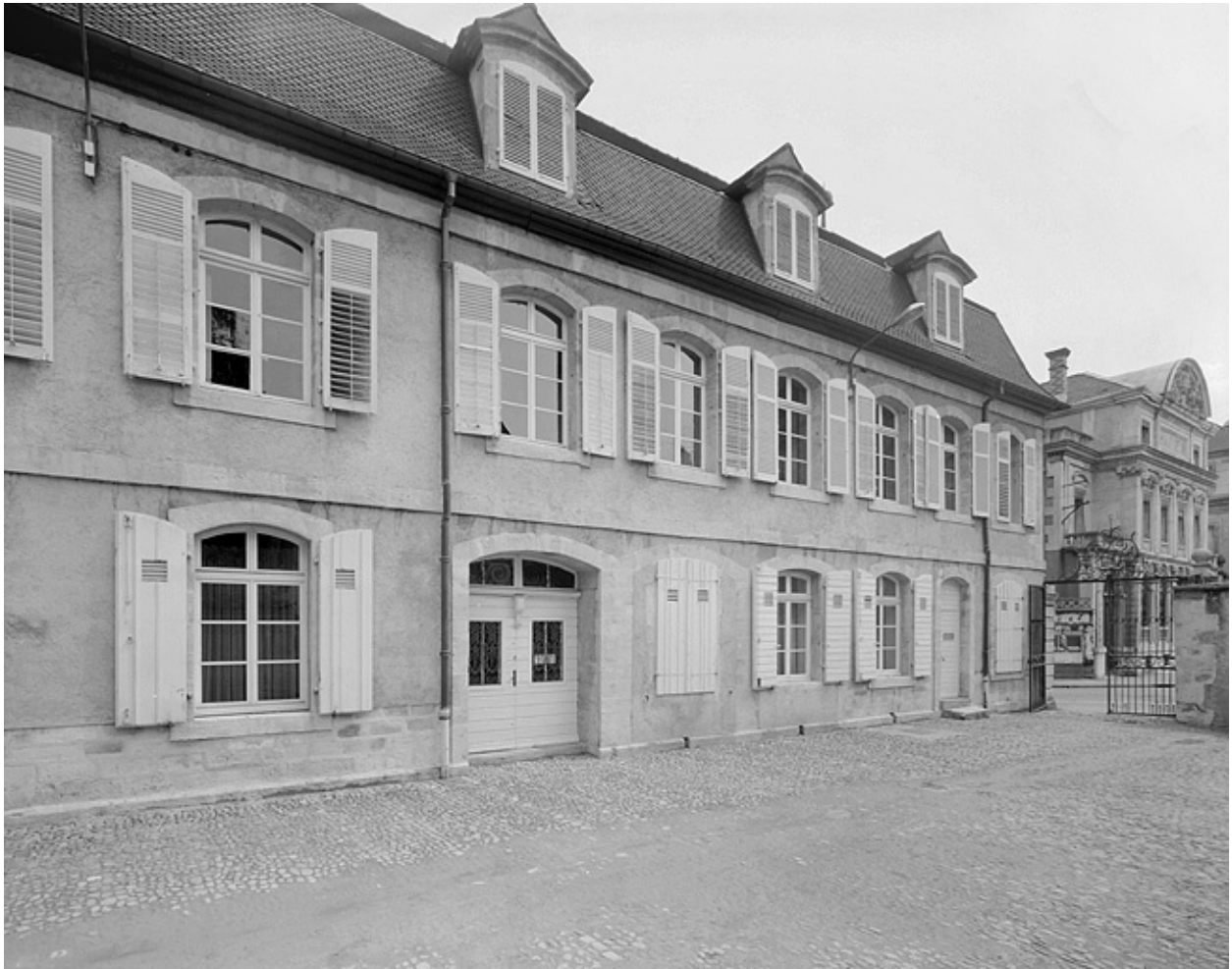
Façade sur cour de l'aile en retour.
