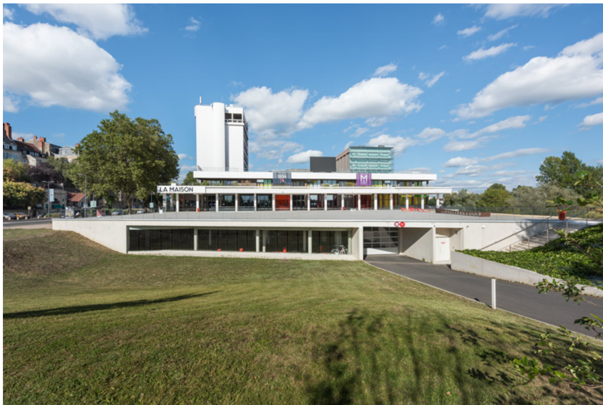
Façade latérale droite.
