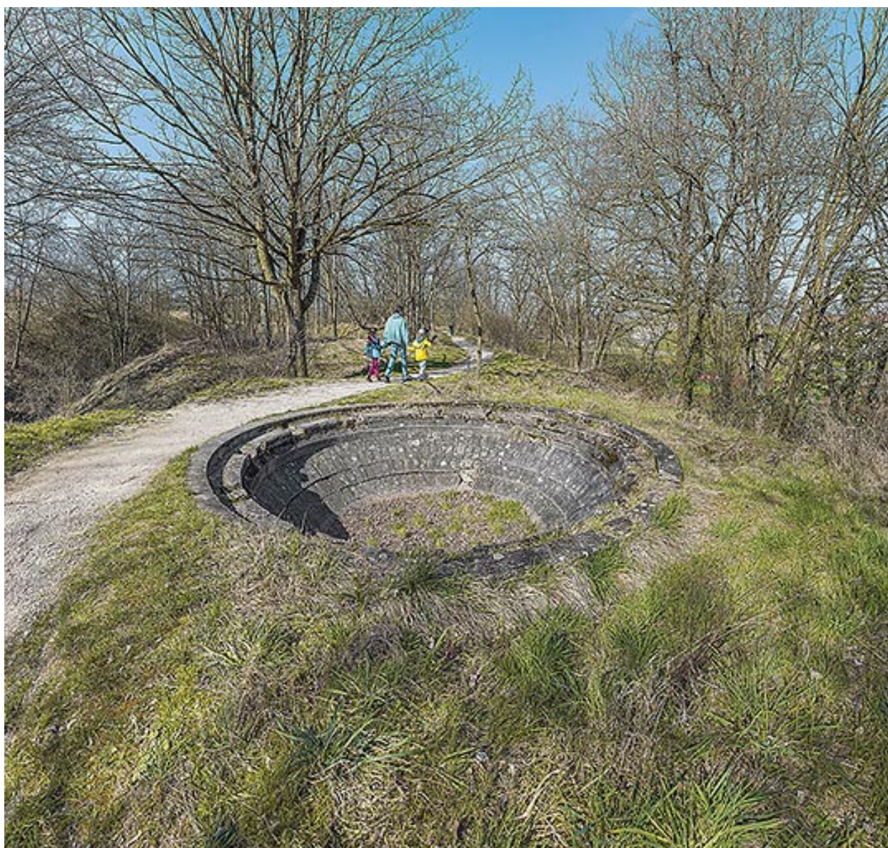
La redoute de Saint-Apollinaire : cuve d'une batterie anti-aérienne.
