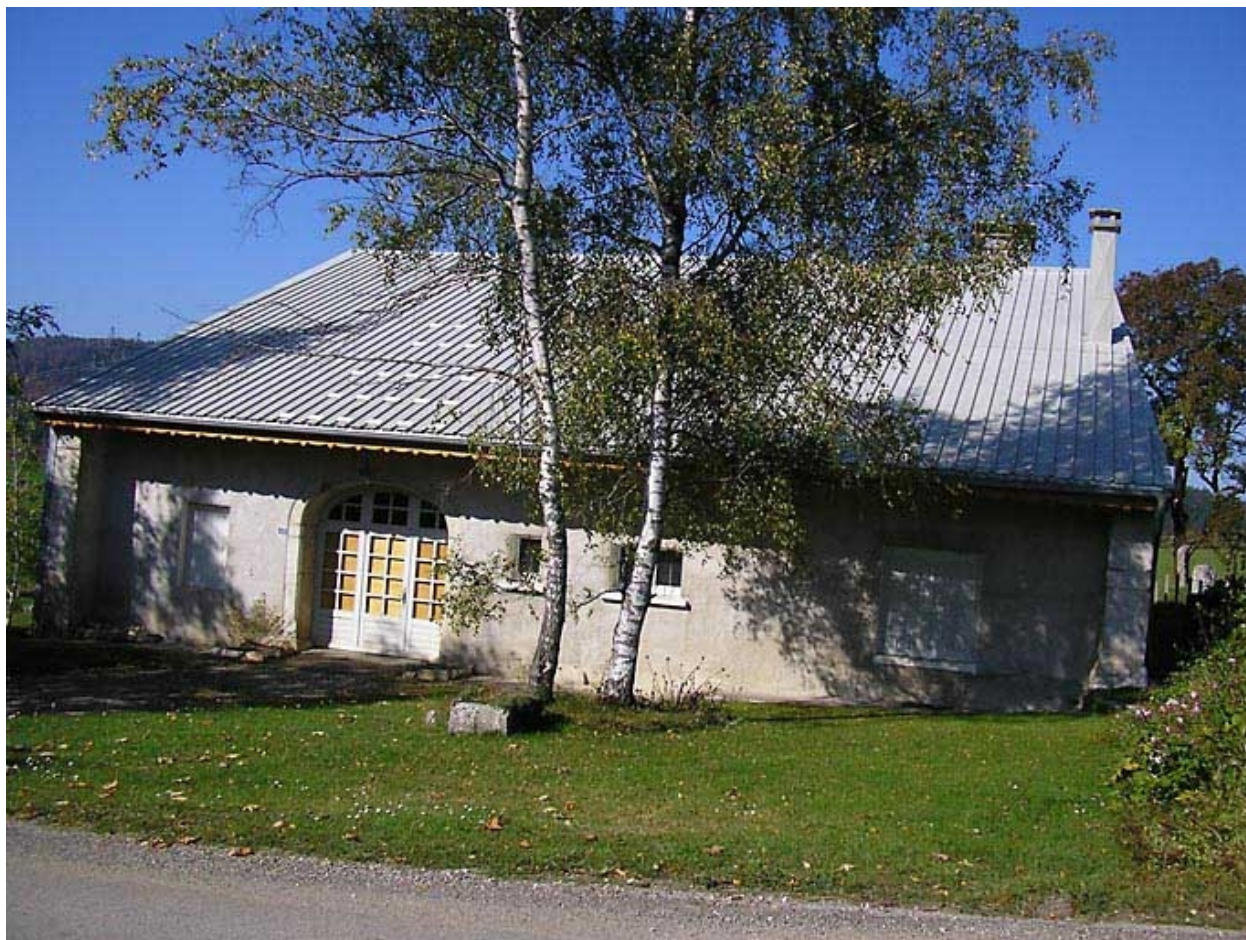
Vue latérale de la façade postérieure.
