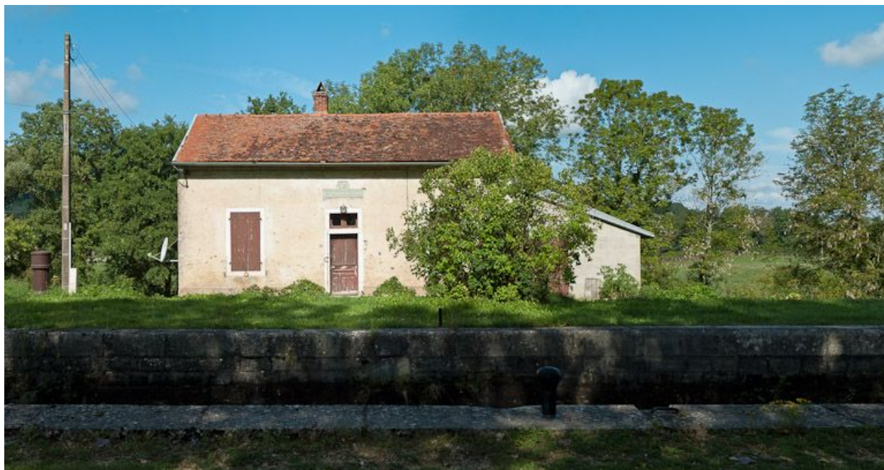
Vue de face de la maison éclusière.
