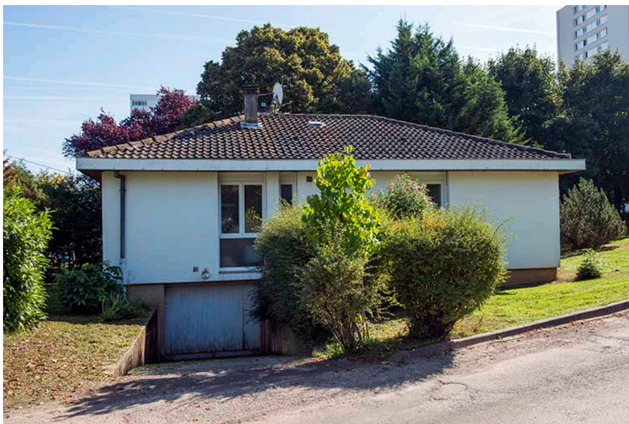
Façade ouest du pavillon logement.
