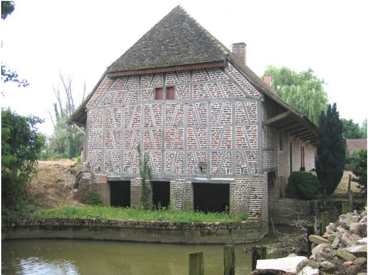
Vue d'ensemble de 3/4 gauche.
